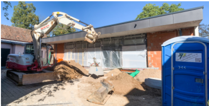
Das Neue Gemeindehaus – Baufortschritt am 25. September ...
