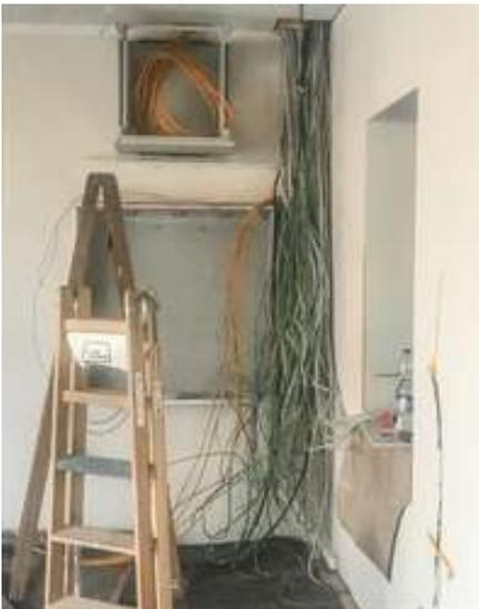
*Da haben die Elektroinstallateure der Fa. Weidmann noch einiges zu tun, um dieses Kabelgewirr geordnet in den beiden Schaltschränken unterzubringen.*
