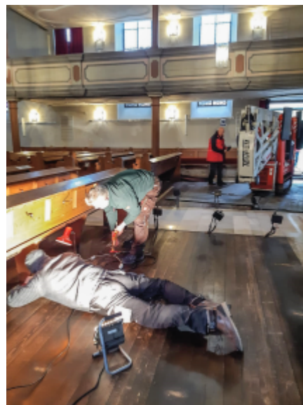
Geschafft, der Steiger ist in der Kirche! Die letzten Bänke werden noch abgebaut.
